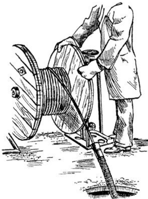
Рис. 13. Размотка кабеля с барабана во время прокладки.
