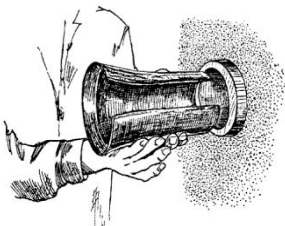
Рис. 11. Установка направляющей воронки на трубу канала кабельной канализации.
