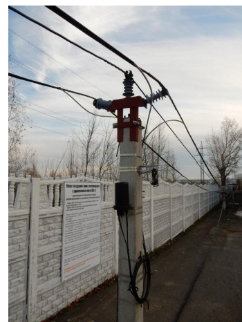
Рис. 26. Вариант исполнения монтажа оптической муфты на проводе СИП-3/ВОК
