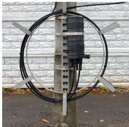
Рис. 23. Вариант исполнения монтажа муфты на устройстве запаса кабеля типа УПМК
