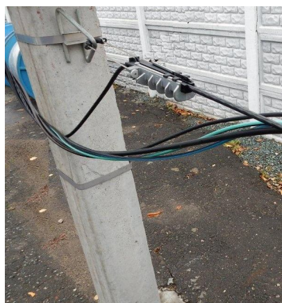
Рис. 19. Вариант исполнения монтажа натяжного зажима на проводе СИП-2/О
