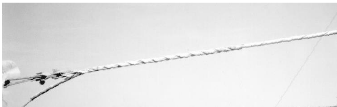
Рис. 24. Смонтированный натяжной спиральный зажим.
